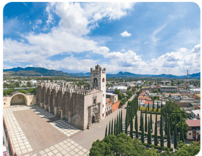
Figura 3.48 Vista del conjunto conventual de Actopan con su capilla abierta.
